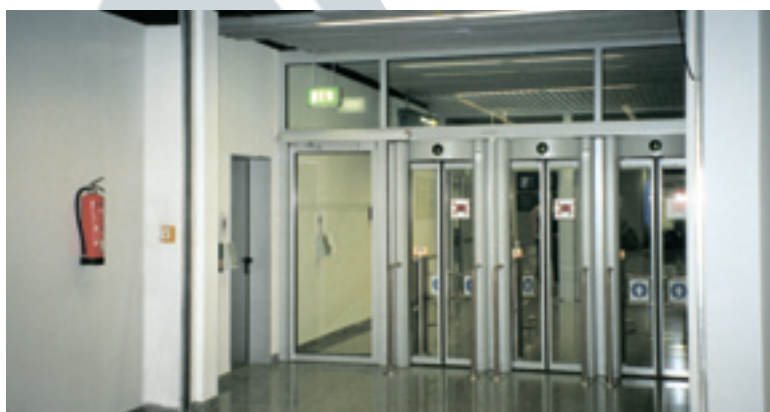
Flughafen Düsseldorf (kombiniert mit Sicherheitsschleuse)
